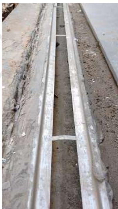
Após o perfil ser assentado sobre o contra piso sobre a aba deve ser aplicado silicone e em seguida o piso/revestimento deve ser assentado sobre a aba.
