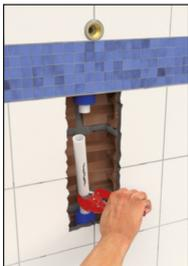
**Passo 6:** Corte um trecho do tubo danificado equivalente ao tamanho de duas luvas mais o trecho do tubo a ser utilizado.
