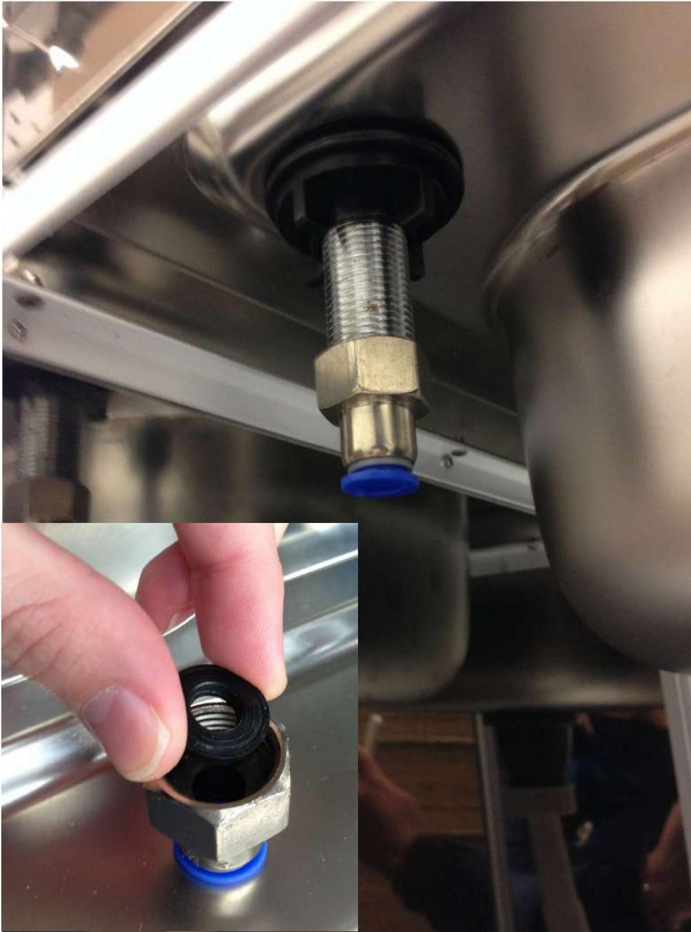
11- Rosquear adaptador encaixe rápido na entrada bica, Verificar se borracha de vedação está dentro do adaptador
