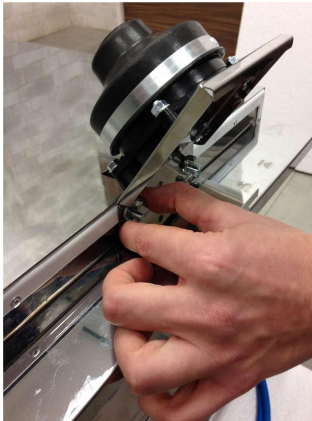
3- Montar a bomba de sucção na base do lavatório com os parafusos e porcas borboletas que já estão juntos no kit. Para facilitar a operação, recomendamos deitar o lavatório lateralmente.
