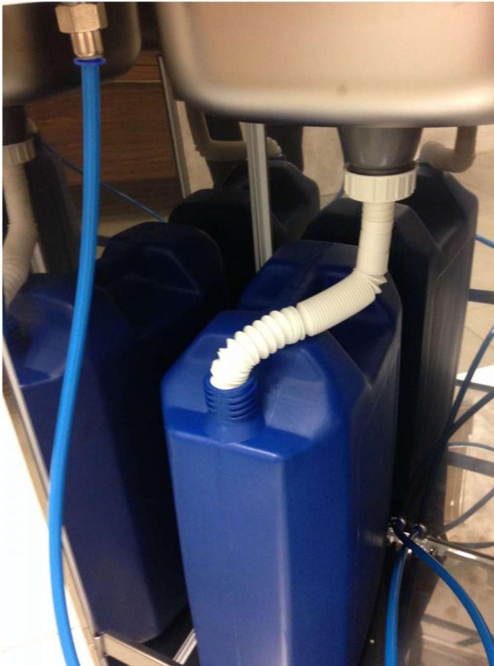
13- Colocar bombona 20l vazia e sifão dentro para água suja usada na lavagem das mãos.
