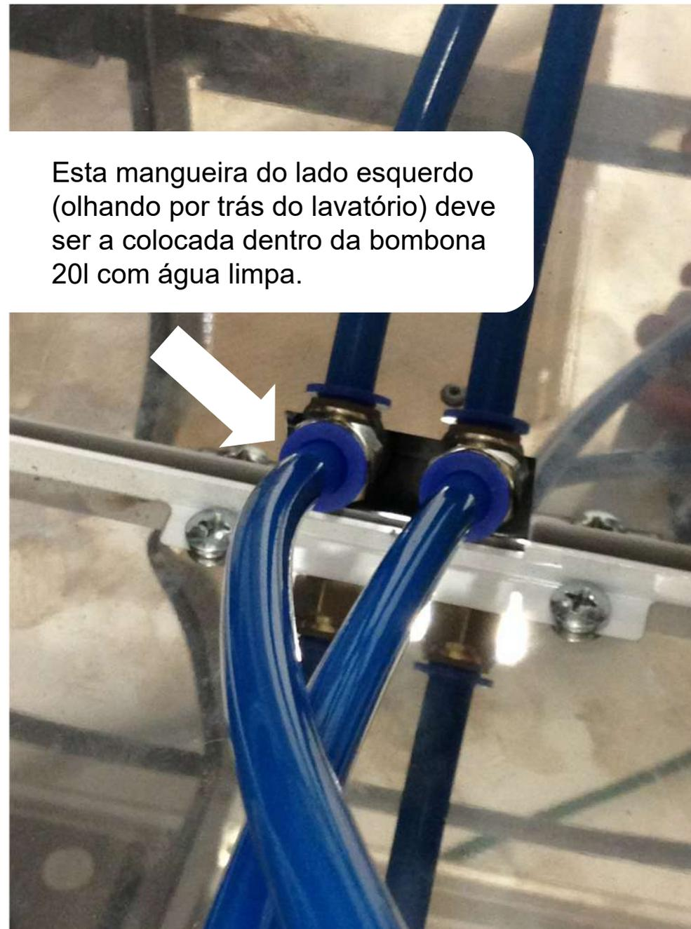
Esta mangueira do lado esquerdo (olhando por trás do lavatório) deve ser a colocada dentro da bombona 20l com água limpa.
