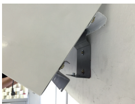
ENCAIXANDO O EQUIPAMENTO
