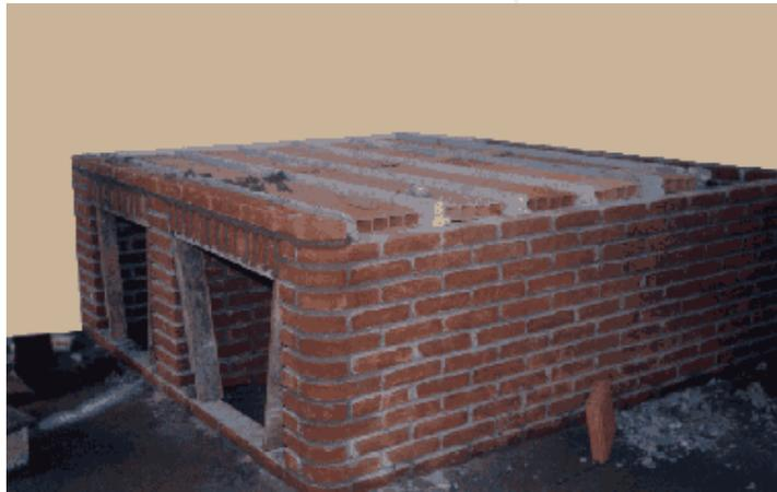
4 - Após a concretagem e secagem da laje, deverão ser assentados os tijolos refratários para a formação da base do forno. Serão usados em média 120 tijolos e 30 quilos de massa refratária. Importante: jamais deverão ser usadas plaquetas refratárias, sendo que o ideal é o uso de placas refratárias tamanho 40 X 40 com alto teor de alumina.
