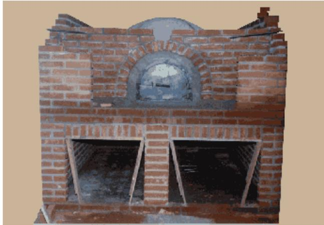
8 - Esta vista da parte frontal do forno mostra o recuo da porta em relação a parede principal do forno. As linhas pontilhadas mostram a posição em que deverá ser construída uma pequena laje entre as paredes frontais deixando-se uma abertura ao centro para que seja colocado o coletor de fumaça.
