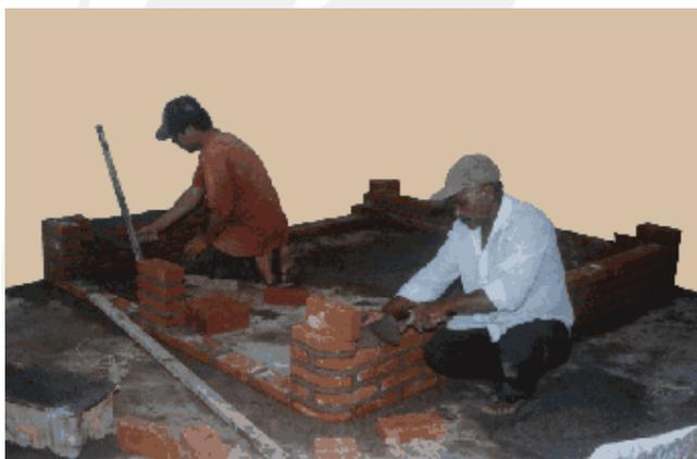
2 - A espessura e resistência dos materiais das paredes é muito importante, pois está diretamente relacionada a vida útil do forno. Quando as paredes alcançarem 1.10 m. de altura, está na hora de determinar o tipo de laje a ser usada.
