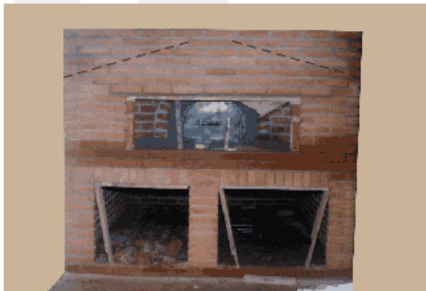
9 - Terminada a construção das paredes, temos aqui uma vista superior, onde vemos a parede frontal dupla e o sistema coletor de fumaça na boca do forno.
