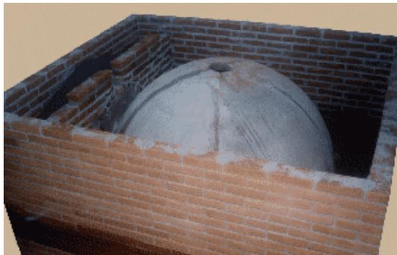
10 - No ponto central superior da cúpula deverá ser colocado o registro do forno, elemento essencial durante a utilização do mesmo. O correto uso deste equipamento faz com que o forno seja mantido sempre na temperatura ideal, evitando assim o superaquecimento da cúpula e em consequência desse aquecimento, trincas que podem danificar o concreto.
