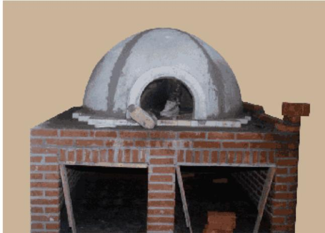
6-As partes do forno são numeradas de 1 a 5 e marcadas com a posição correta de cada peça, facilitando o trabalho de montagem da cúpula. Após o término da colocação das peças, a cúpula deverá ser rejuntada interna e externamente com o uso de massa refratária. Posteriormente a esse trabalho, é dada seqüência à construção das paredes laterais.
