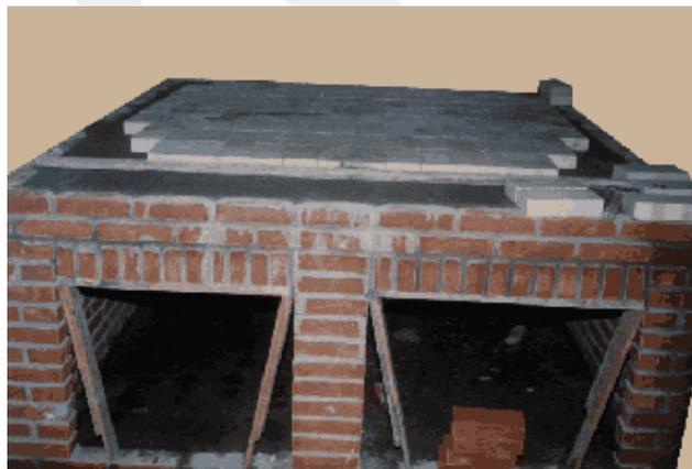
5 - As partes do forno serão posicionadas partindo do fundo para a frente, deixando-se mais ou menos 15 cm de espaço entre a cúpula e a parede traseira e centralizando-a em sentido contrário. Haverá uma folga maior na parte frontal que será usada na captação de fumaça.
