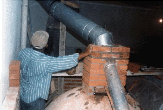
13 - Quando houver necessidade de curvas na chaminé, só utilize as de 45°. Se o espaço onde o forno será montado exigir o uso de curvas de 90° e chaminé horizontal, torna-se necessário o uso de exaustor para que não haja retorno de fumaça e acúmulo de fuligem no tubo.
