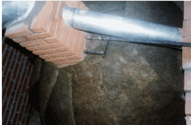
15 - O próximo passo será a colocação de tela metálica ( do tipo usado em galinheiro ) por sobre a manta isolante, para que a mesma não se movimente nos próximos passos da construção.
