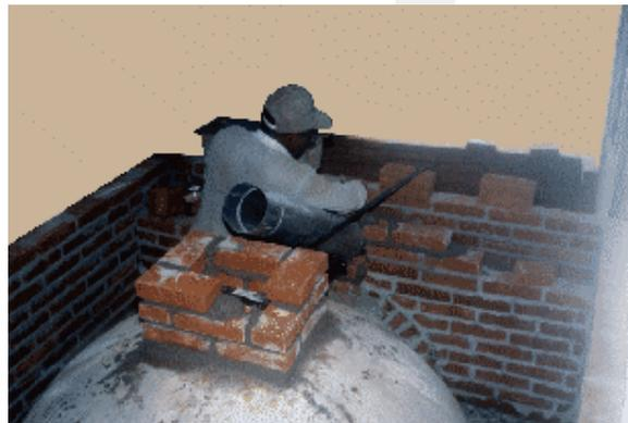
12 - A chaminé principal deverá ser executada em tubos de chapa ( aço carbono ou galvanizada ), nunca em alvenaria. O peso de vários metros de chaminé construída no topo da cúpula impedirá a dilatação podendo ocorrer trincas nas partes do forno.
