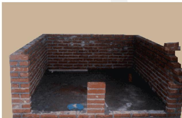
3 - Quando optar por laje pré-fabricada, deverá ser construída uma parede central para reforço de estrutura. Usando-se laje maciça, o reforço é desnecessário.
