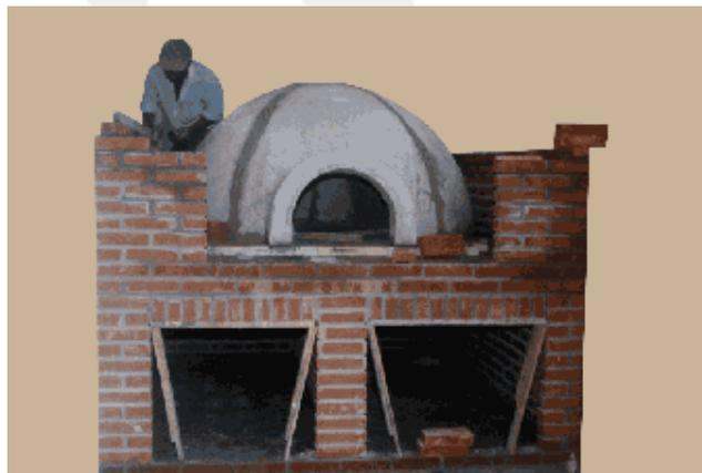
7 - Após todo o fechamento das laterais, deverá ser chumbada a porta do forno e posteriormente iniciada a construção da parede dupla frontal.
