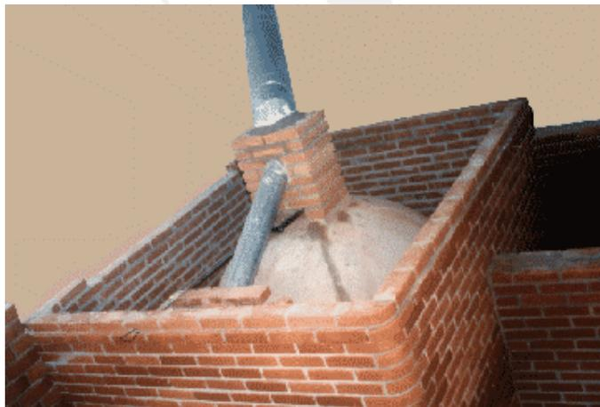
14 - Após a montagem da chaminé, a cúpula deverá ser envolta em manta de lã de rocha ou fibra cerâmica, garantindo assim um perfeito isolamento térmico, o que fará com que o forno tenha vida útil maior e consumo de lenha menor.
