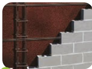
**3** Levantamento das paredes e aplicação do reboco liso.
