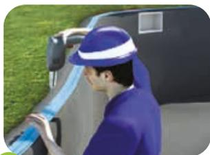
**5** Instalação dos dispositivos, dreno de fundo, skimmer e refletores. Fixação do perfil de PVC em toda a borda da piscina.
