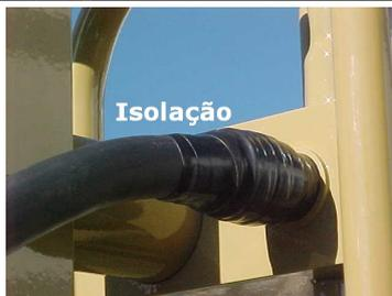
Isolação da conexão
