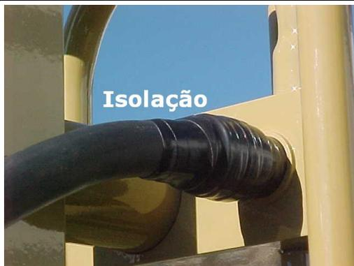
Isolação da conexão
