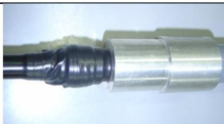
Isolação da conexão
