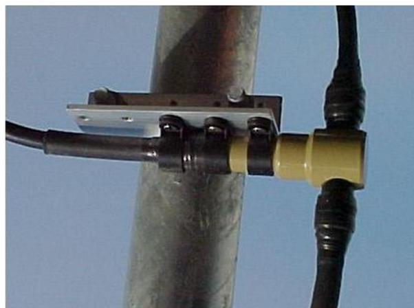
VII- Conexão dos cabos e isolamento dos conectores. É necessário fazer a vedação das conexões, respectivamente, com fita isolante plástica, fita de auto-fusão e, novamente, com fita isolante plástica.
