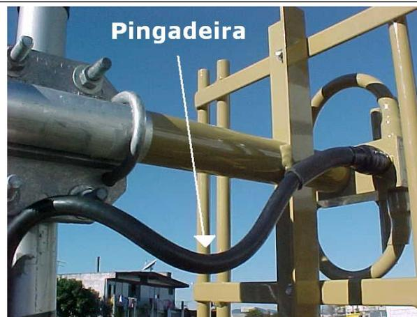
VIII – Outros cuidados. Faça uma “pingadeira” para que a água da chuva não escoe para a conexão. Não esqueça de estabelecer um contato metálico entre os grampos do suporte e a torre. Isto é importante para proteger a antena de tensões induzidas e aterrar sua estrutura para descarga estática. Para maiores informações sobre aterramento, consulte o Código Nacional de Eletricidade. Fixe bem o cabo de alimentação com cintas plásticas, de modo que fique bem preso e não oscile com o vento.
