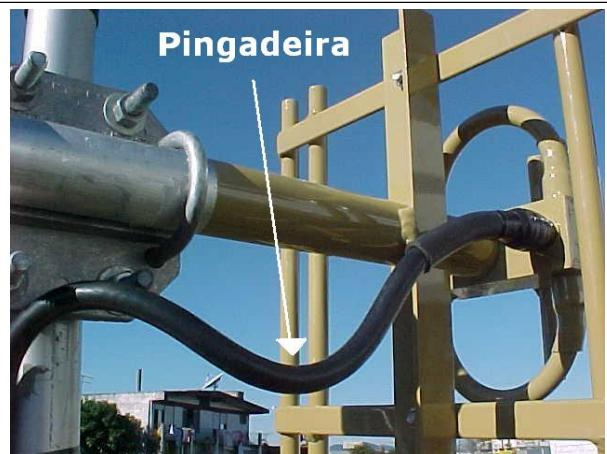
VIII – Outros cuidados. Faça uma “pingadeira” para que a água da chuva não escoe para a conexão. Não esqueça de estabelecer um contato metálico entre os grampos do suporte e a torre. Isto é importante para proteger a antena de tensões induzidas e aterrarr sua estrutura para descarga estática. Para maiores informações sobre aterramento, consulte o Código Nacional de Eletricidade. Fixe bem o cabo de alimentação com cintas plásticas, de modo que fique bem preso e não oscile com o vento.
