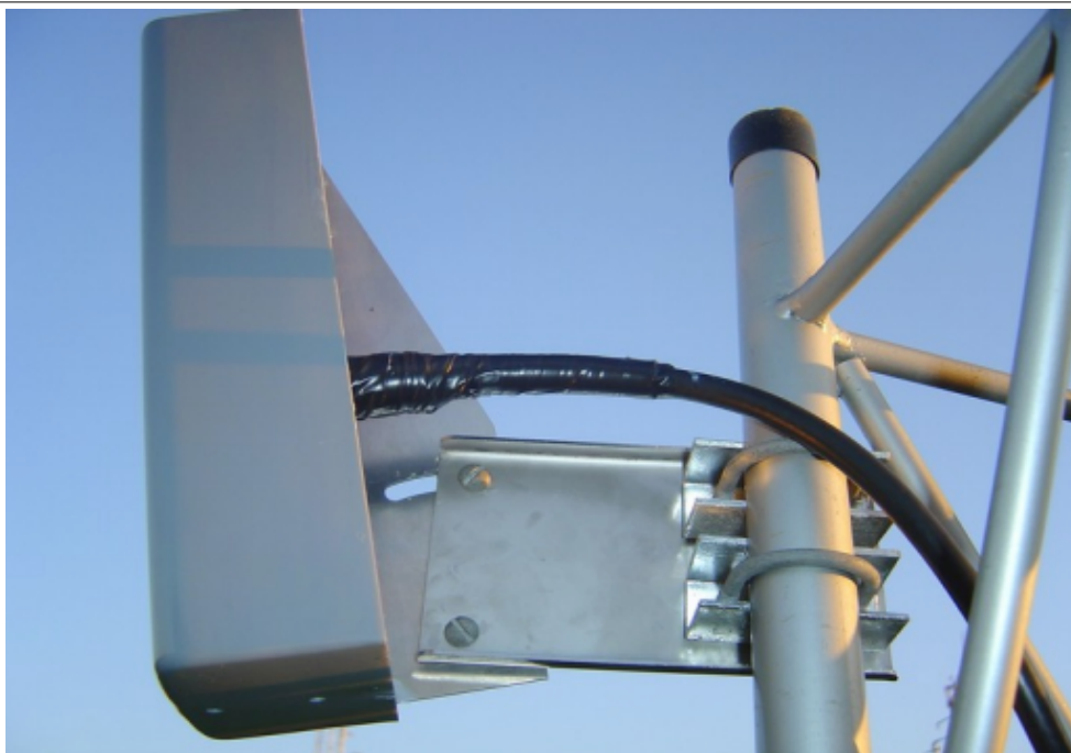
Isolação da conexão.
