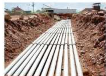
TUBULAÇÕES METÁLICAS K-10
